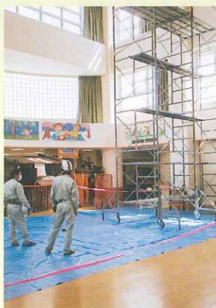
補強工事中の地域交流ホール
