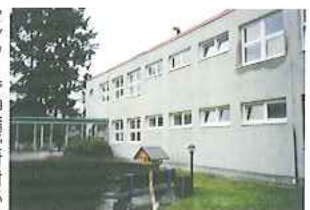
▲センター運営の施設。古い建物であるが維持管理は行き届いている
