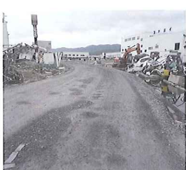
▲がれきをかき分けて作られた道路
